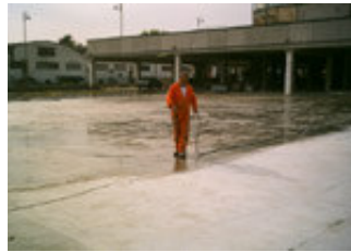
Centro commerciale Cosmo Ancona
