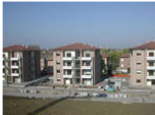
Construcție rezidențială Acropoli, REGGIO EMILIA - 1.000 mp
