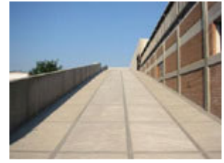
Rampa de acces Centrul comercial MARMIROLO (MN) - 4.000 mp
