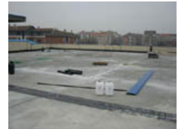
Pardoseală industrială, Via Vandalino, Torino, Italia - 1.100 mp
